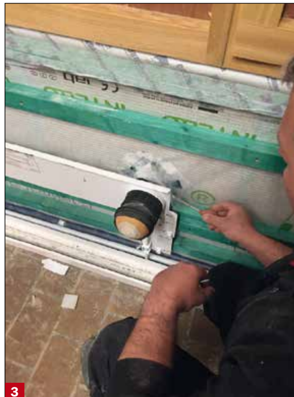
3 De realisatie van een goede luchtdichtheid wordt zeer sterk bepaald door een zorgvuldige uitvoering op de bouw (foto: architectenkantoor AR-TE)
