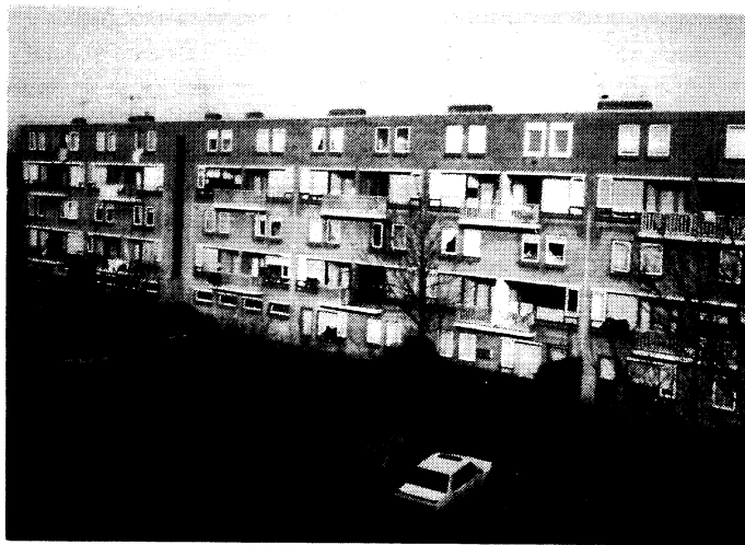
De 112 woningen in Hoorn hadden veel problemen met vocht en ventilatie.
