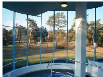
Abbeiding 1 > Zonnestraal, Hilversum; transparantie van binnen naar buiten door slanke profielen
