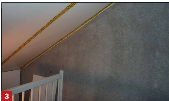
3 Tape als luchtdichting
