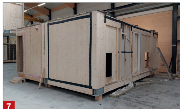
Impressie van de meetopstelling (wanden CLT)
