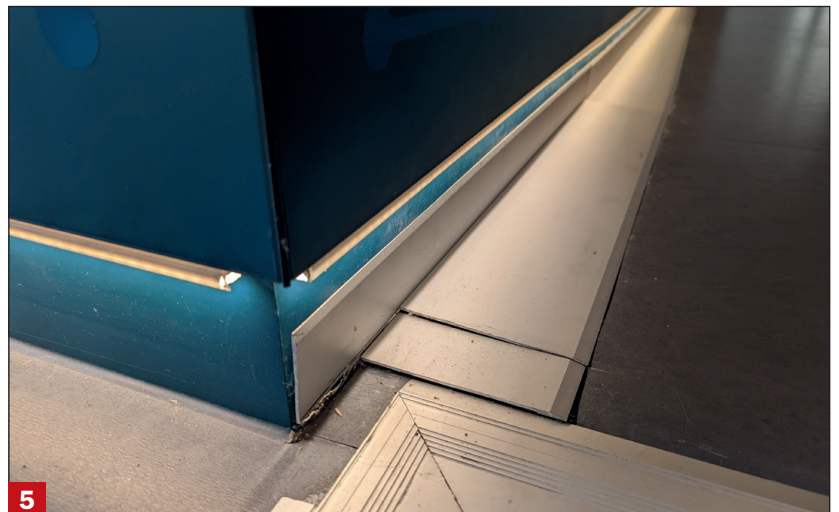
Speciale plinten dekken de dilatatievoegen rondom de zalen af
