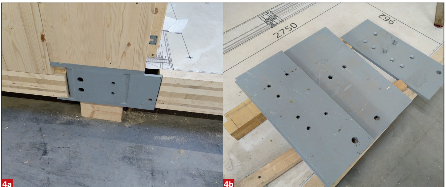
Detail stalen schoen met daarop de houten kolom en verbindingssplaat
