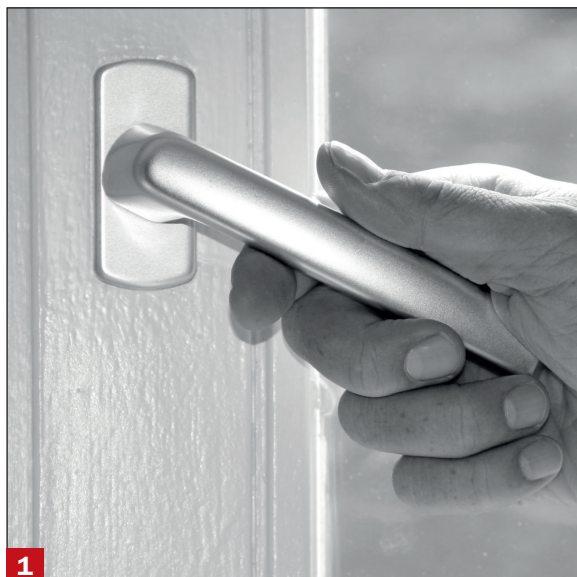
Voorbeeld 1 controlemiddel: te openen raam
