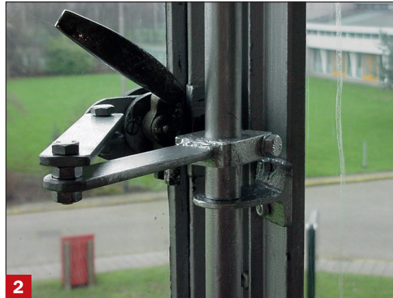
2 Draaistang te openen ramen Van Nelle: bestaande draaistangen voor bovenramen zijn gebruikt voor automatisch openen van de ramen. Standaard techniek uit kassenbouw
