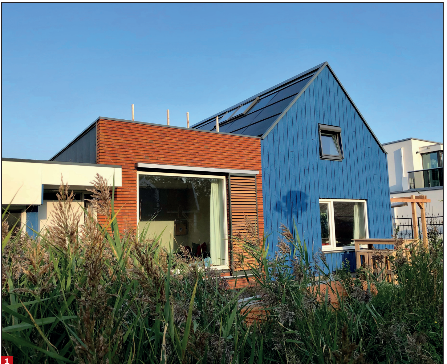
1 De woning, gezien vanuit het westen
