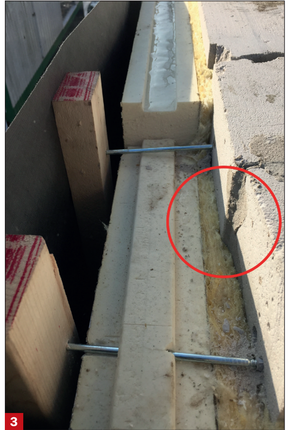
3 Harde isolatieplaten met zachte minerale wol om valse spouwen te voorkomen
