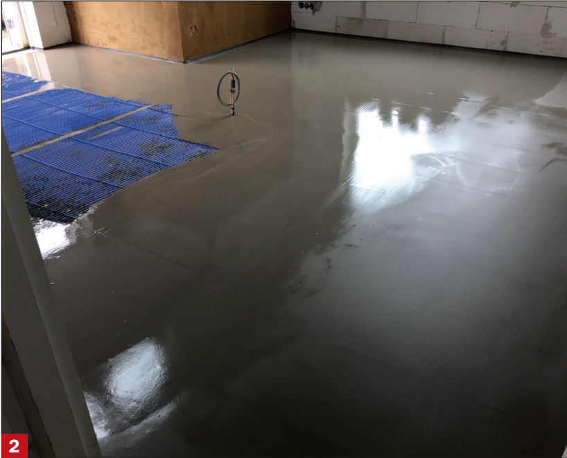
2 Capillaire vloerverwarming in de toplaag van de keukenvloer
