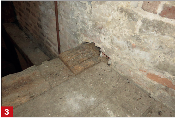
3 De houten balkkop is weggerot en sluit niet meer aan op het metselwerk
