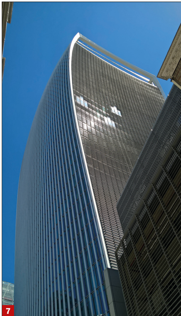
Het inmiddels van een brise-soleil voorziene gebouw in Londen (foto Roel Schipper, juni 2017)
