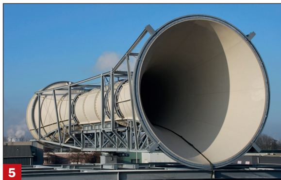
5 Invelox-systeem met HAWT in kanaal op dak gebouw (Gereproduceerd met toestemming van Rein Kroezemann)
